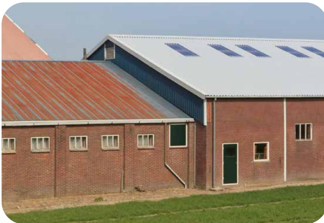
La plaque Elyplast en polyester renforcée de fibre de verre est la solution idéale pour les toitures, grâce à sa bonne résistance mécanique, durabilité, légèreté et facilité de maniabilité.
